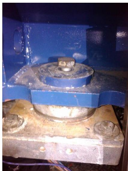
圖 15、未鎖固完全之發電機基座螺栓
