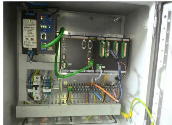
圖 11、資料處理模組(3 組類比輸入、9 組壓電輸入、1 組計數器、1 組編碼器、1 組網路埠、1 序列埠)
