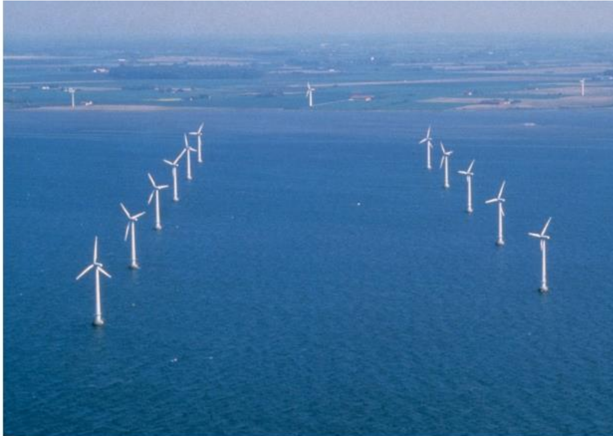
Vindeby Offshore Wind Farm (Photo: Vindmølleindustrien)
