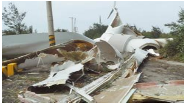
圖八 我國既有風力發電機組曾經發生過風力機遭颱風吹倒
